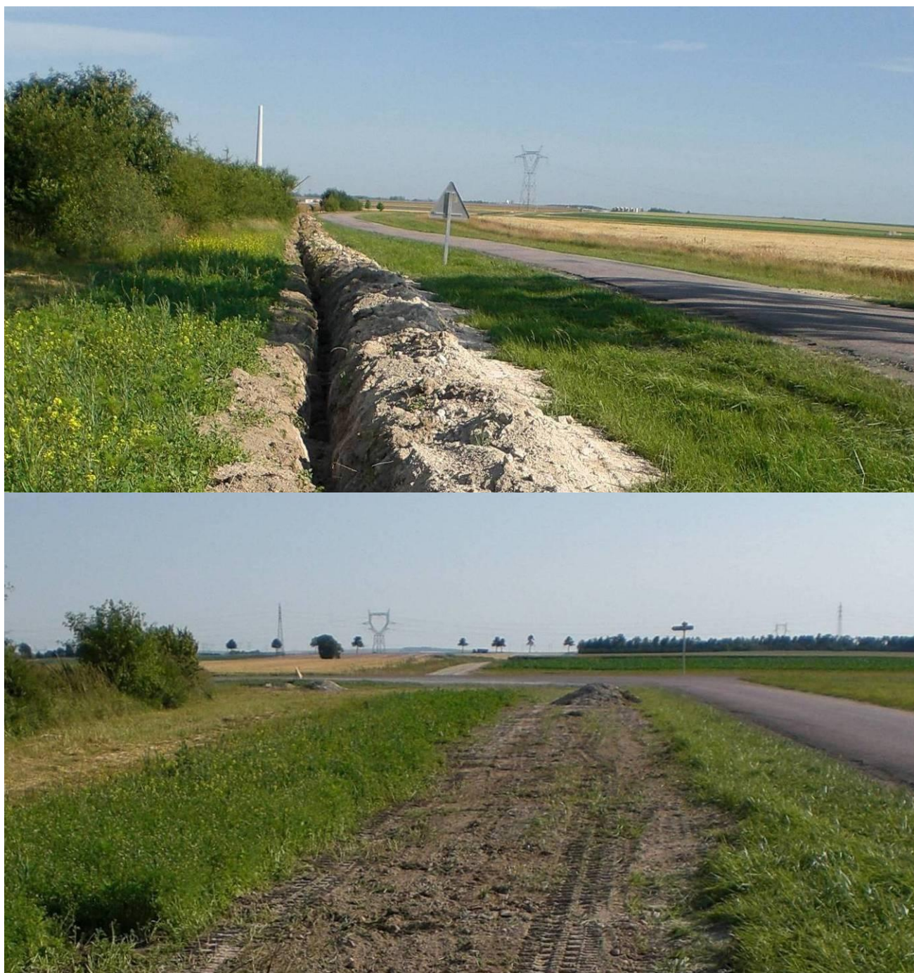
Photo 62 : Rebouchage de tranchée après passage des câbles électriques (Source : BE JC)
